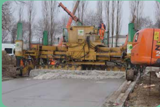
Aanleg van de cementshoudende toplaag met fotoactief titaandioxide op het bedrijventerrein Den Hoek 3 in Wijnegem.
